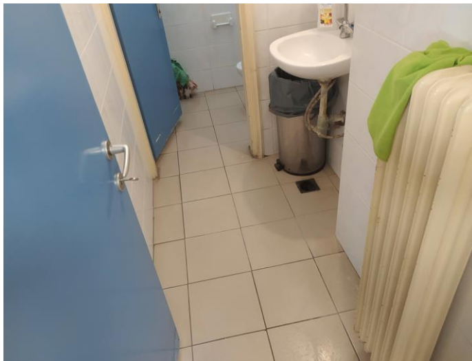
Οξειδωμένα θερμαντικά σώματα τύπου ΑΚΑΝ (Φέτες) και σπирάλ σύνδεσης στα WC
