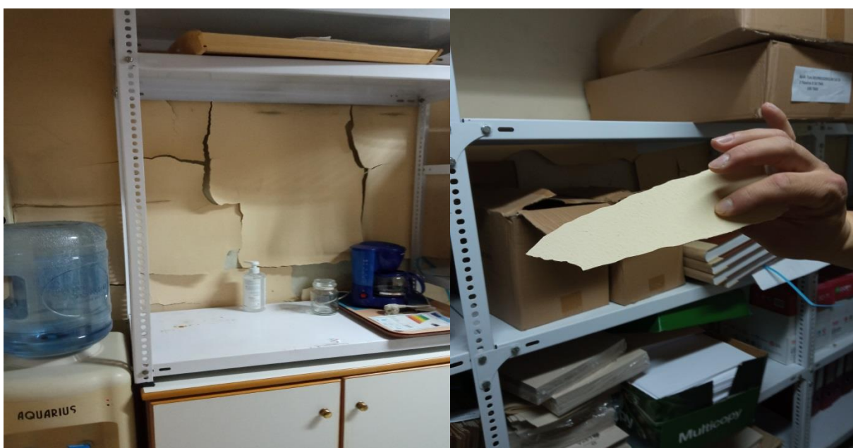
Εικόνα 6: Άποψη αποφλοιώσεων εσωτερικών χρωματισμών τοιχοποιίας στον Β' όροφο της Η' Τ.Δ. Θεσσαλονίκης του e-ΕΦΚΑ , στον Εύοσμο
