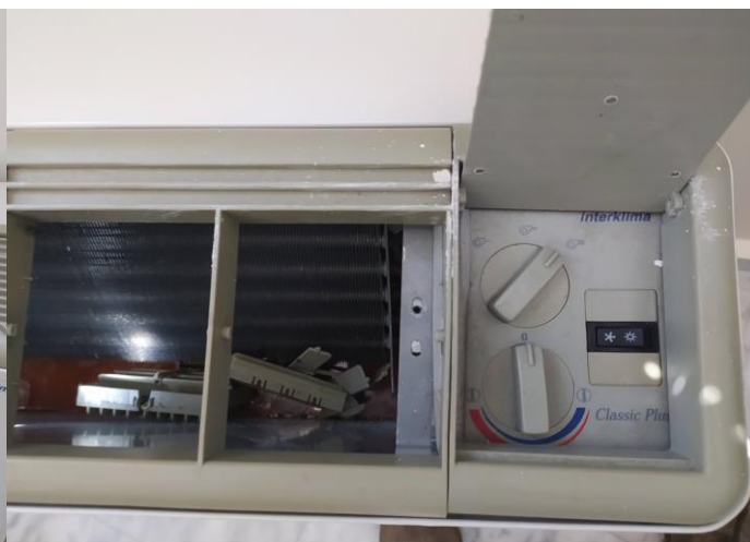
Φθορά σε θερμαντικό σώμα τύπου FCU δαπέδου
