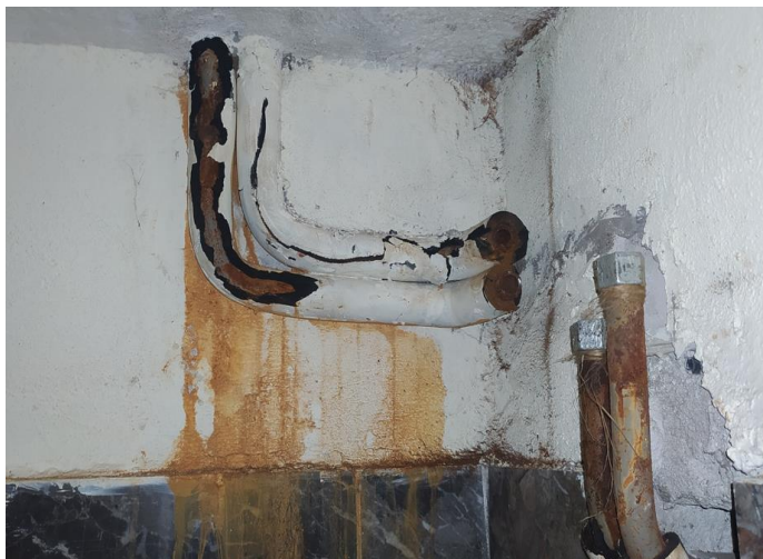
Οξειδώσεις στο δίκτυο μεταφοράς του νερού της θέρμανσης και της ψύξης
