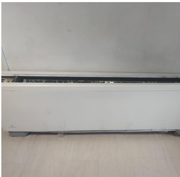
Φθορά σε θερμαντικό σώμα τύπου FCU δαπέδου
