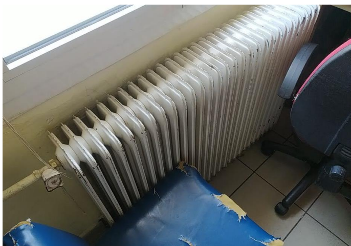
Οξειδωμένα θερμαντικά σώματα τύπου ΑΚΑΝ (Φέτες)
