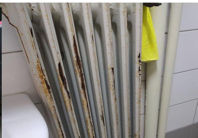
Οξειδωμένα θερμαντικά σώματα τύπου ΑΚΑΝ (Φέτες) στα WC
