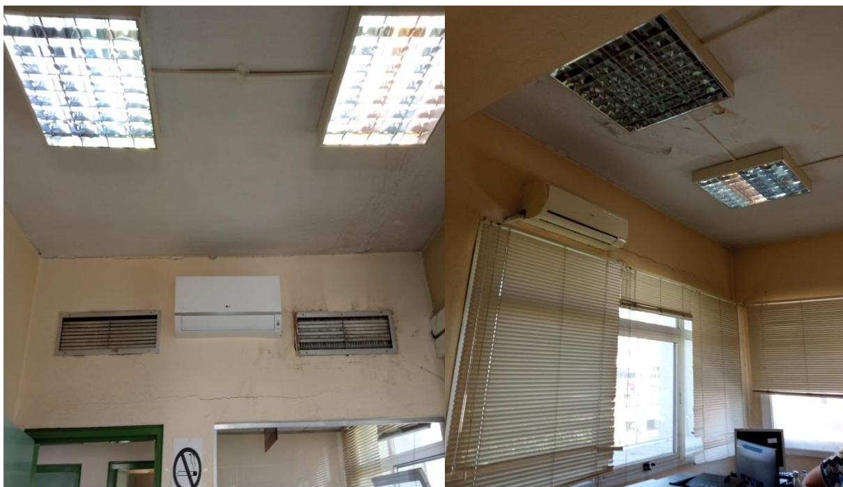
Εικόνα 5: Άποψη υγρασιών και ρηγματώσεων της οροφής του Β' ορόφου της Η' Τ.Δ. Θεσσαλονίκης του e-ΕΦΚΑ , στον Εύοσμο
