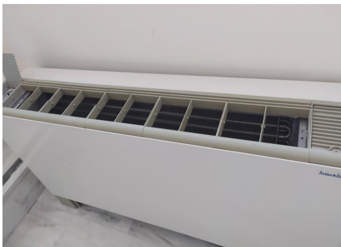
Φθορά σε θερμαντικό σώμα τύπου FCU δαπέδου
